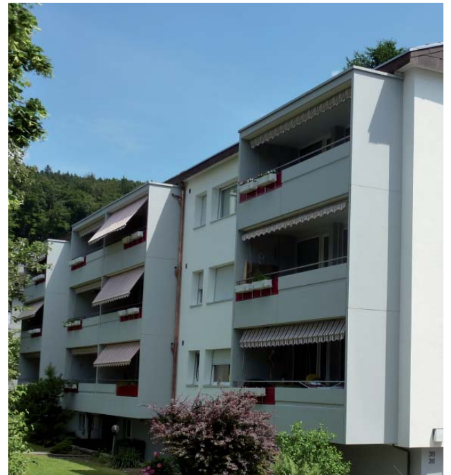
Nach der erfolgreichen energietechnischen Sanierung benötigt das Mehrfamilienhaus in Rüfenacht über 12'000 Liter weniger Heizöl.
