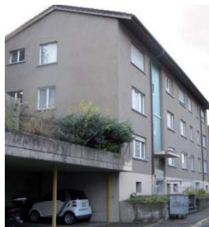
Gebäude vor der Sanierung.
