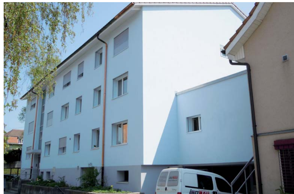
Das Gebäude am Weierbühlweg 1 und 3 in Köniz sieht nach dem Sanieren nicht nur ästhetisch schöner aus, sondern spart fast 60% des Heizölverbrauchs ein.
